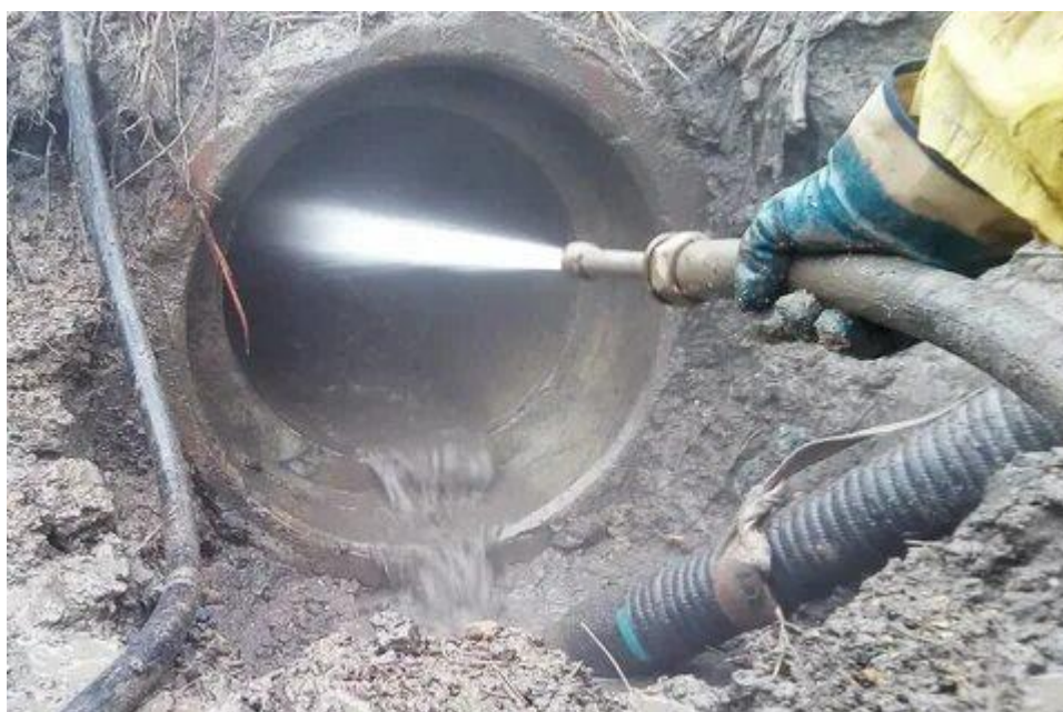
Рисунок 2. Очистка труб с помощью гидромонитора.
